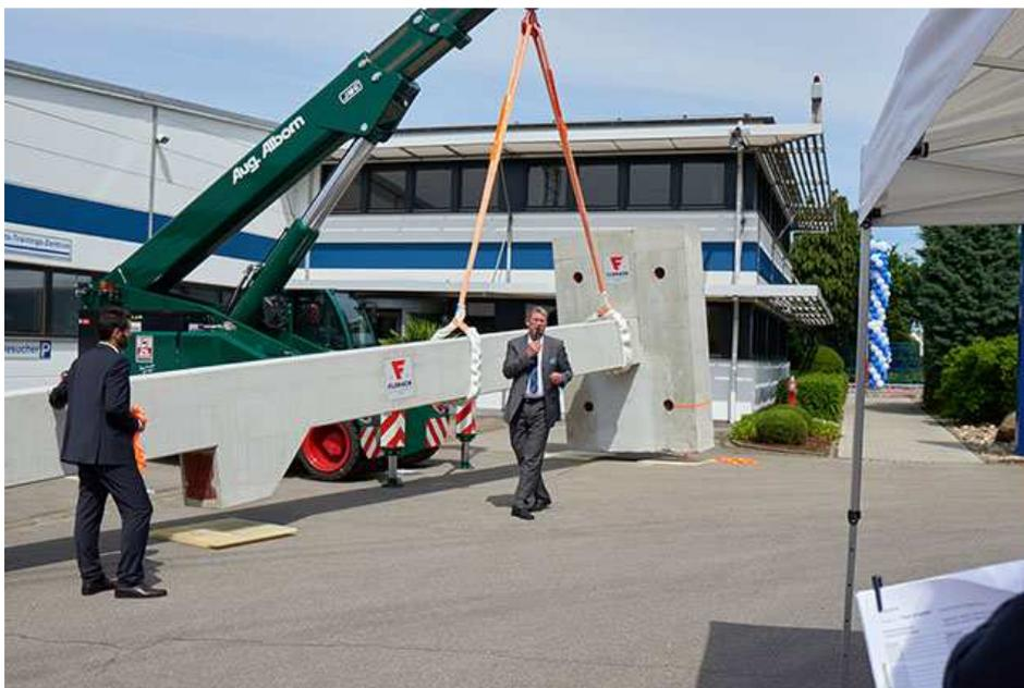
*Abb.6: Ein Betonpfeiler mit Sockel wird mit Magnum-X Schwerlastschlingen waagrecht angehoben.*
