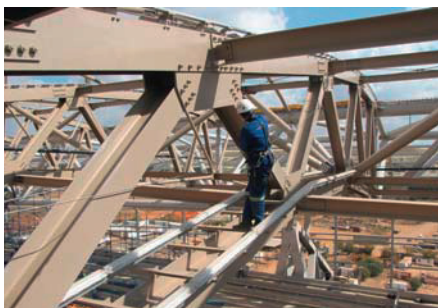
Eine typische Bauanwendung (Soccer City Sports Stadium – Südafrika)
