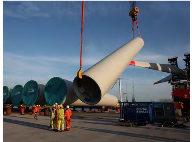
Hebevorgang einer Turmsektion mit Axzion J-Hook und Axzion Pulley
