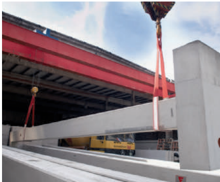
secutex-Schutzschlauch SF-1 Schnittfeste secutex-Beschichtung schützt zuverlässig vor scharfen Kanten.
