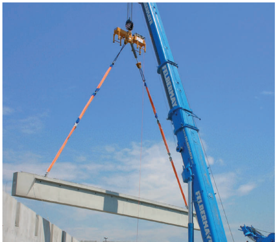
Hydr. Setztraverse für Brückenteile
